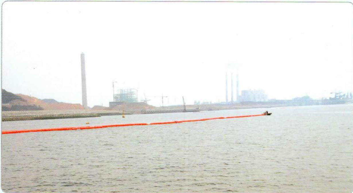
▲신형 오탉방지막(일체형) 설치 전경: 영흥화력발전소현장)
